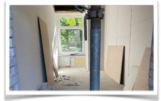
Kleiner Zwischenstand - hier entsteht eine Umkleidekabine
